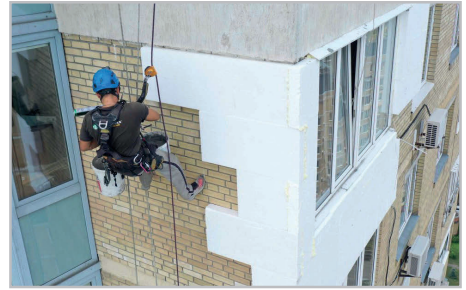
Утеплення стін будинку
